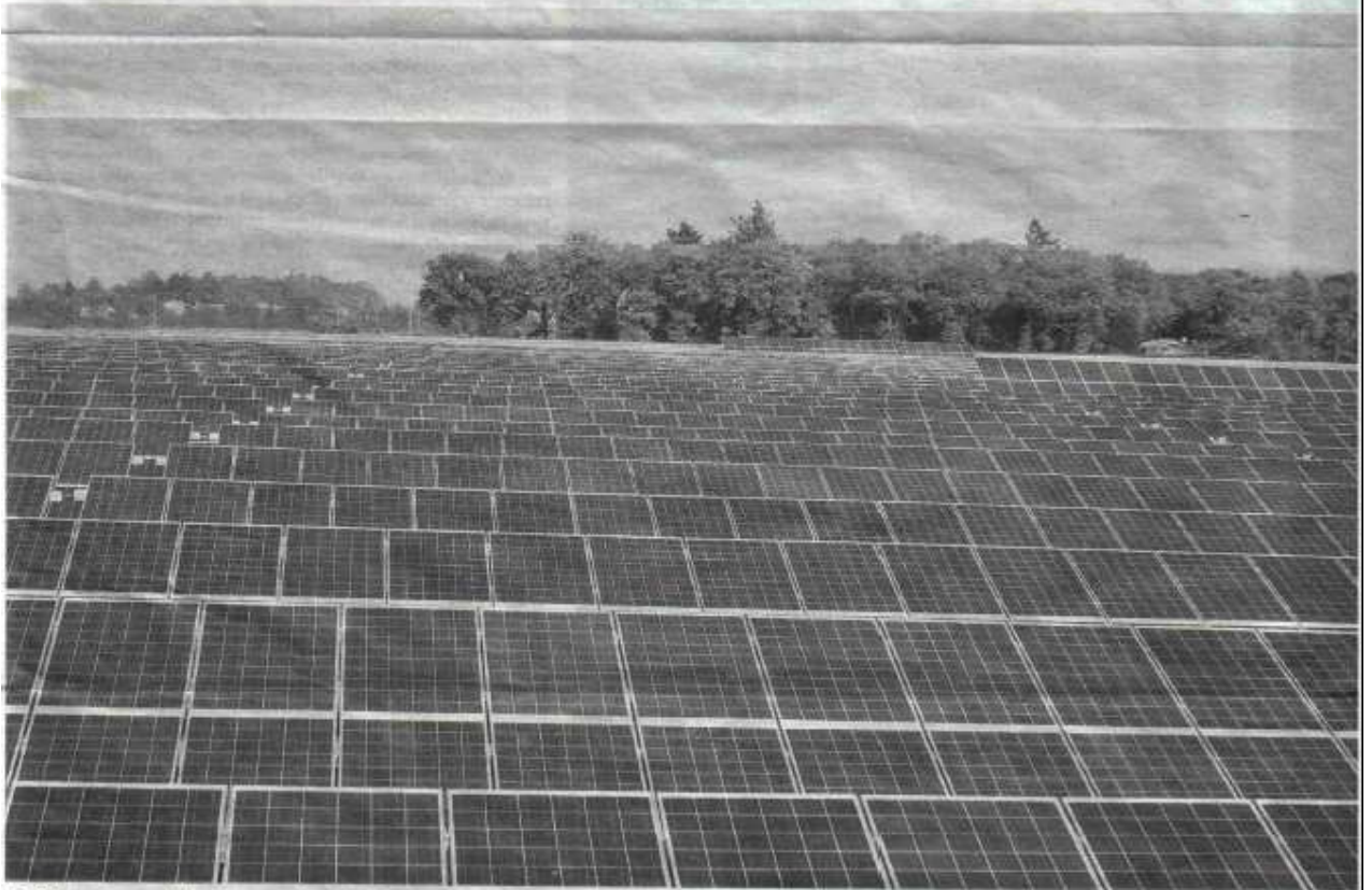
35 000 panneaux installés sur un parc de plus de 17 hectares sur la commune de Montéléger.
